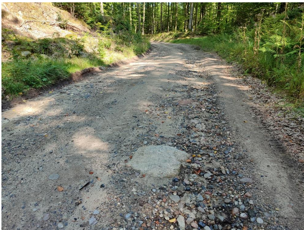
Fot. Uszkodzenia nawierzchni drogi leśnej
