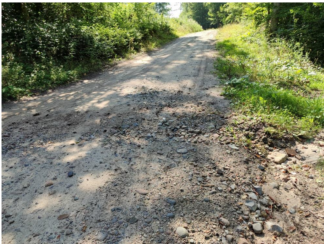
Fot. Uszkodzenia nawierzchni drogi leśnej
