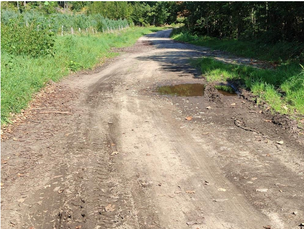
Fot. Uszkodzenia nawierzchni drogi leśnej
