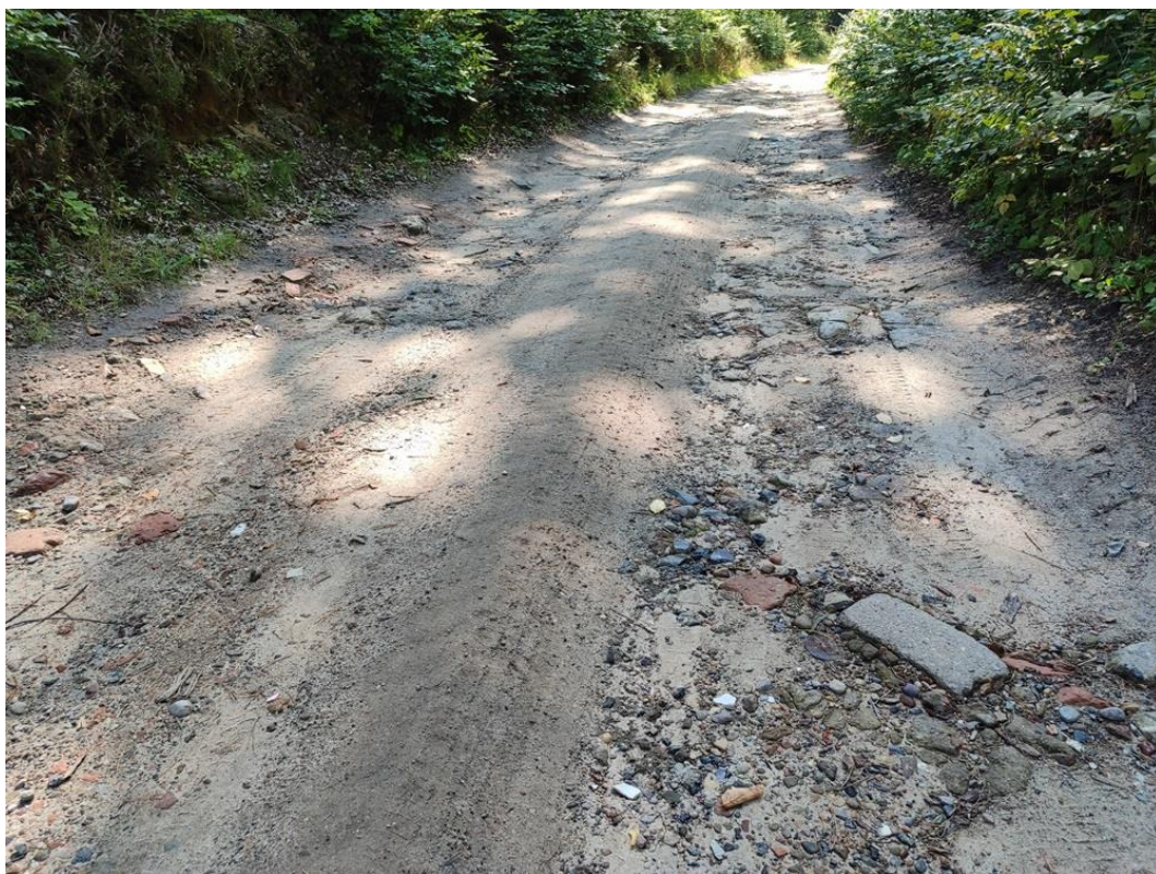
Fot. Uszkodzenia nawierzchni drogi leśnej
