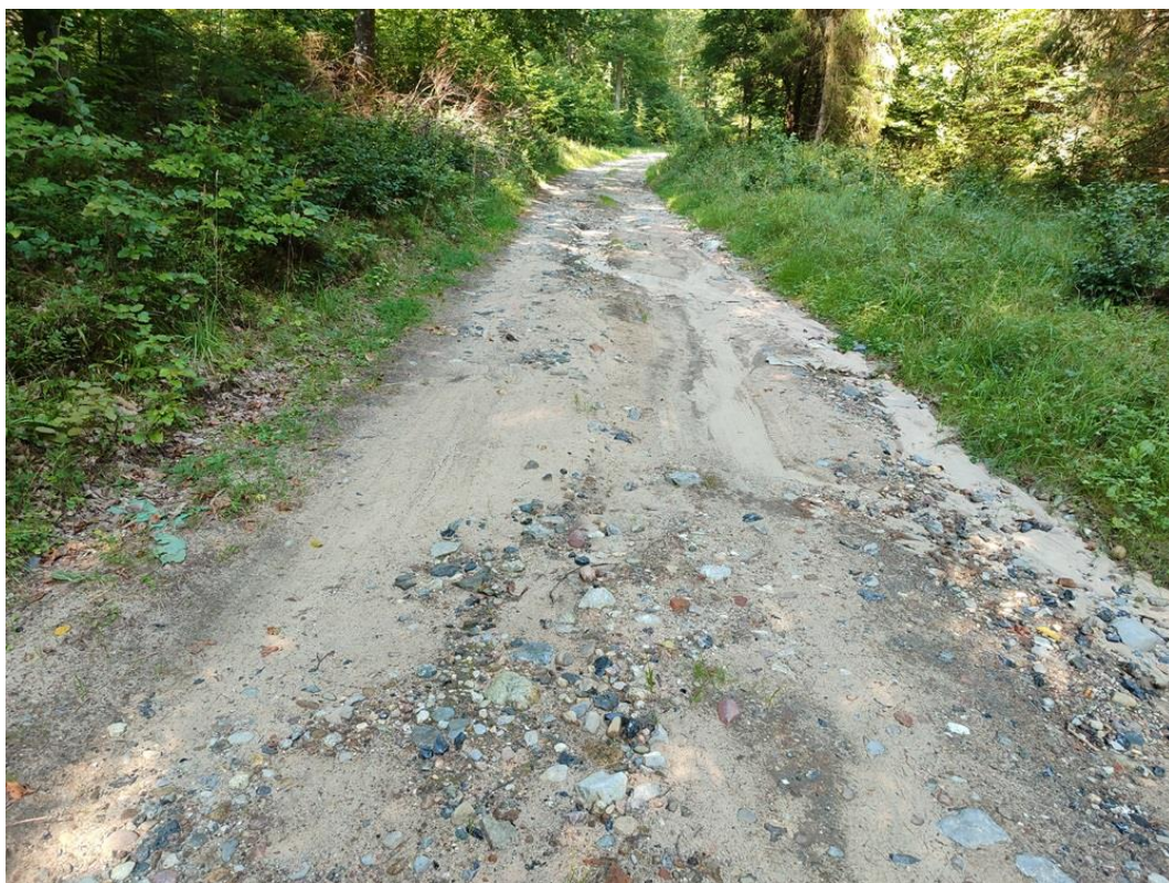
Fot. Uszkodzenia nawierzchni drogi leśnej
