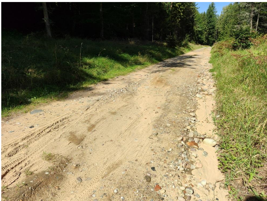
Fot. Uszkodzenia nawierzchni drogi leśnej
