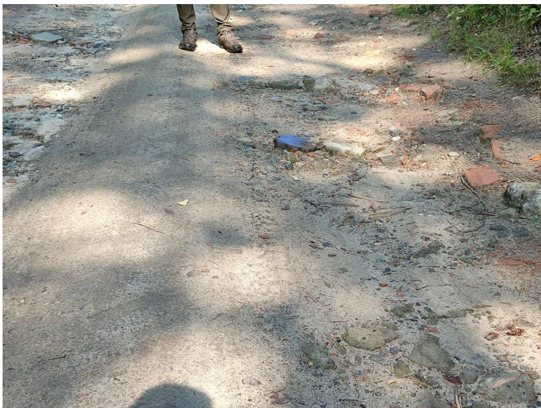
Fot. Uszkodzenia nawierzchni drogi leśnej
